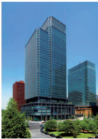
写真 2 新丸の内ビルディング Photo 2 Shin-Marunouchi Building
