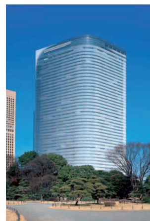
写真 3 電通本社ビル Photo 3 Dentsu Building
